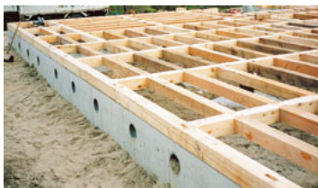
1階床下耐震剛床工法
